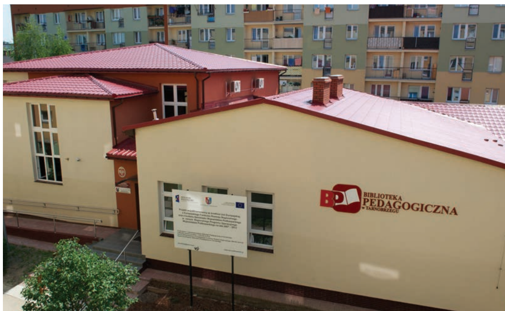
Budynek Biblioteki Pedagogicznej współcześnie
